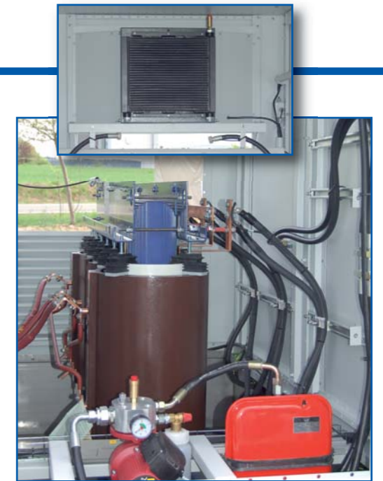
Optimiertes Kühlsystem für alle Klimazonen mit Wasserkühlung für Wechselrichter und / oder Transformator.
