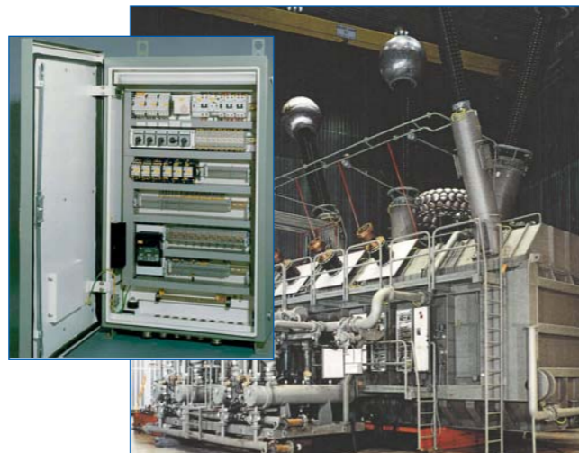
Überwachungs- und Kühlanlagensteuerung für einen 400 MVA Großtransformator
