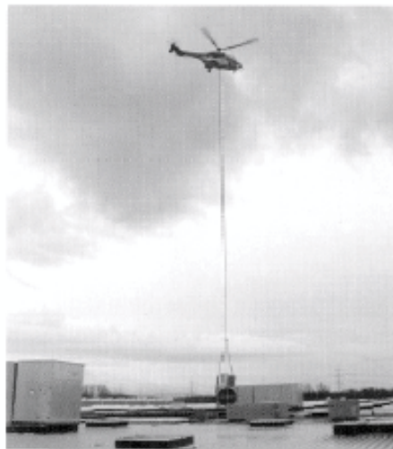
Gekonnter Einsatz in der Luft: Lieferung von schweren Lasten für die neue Montagehalle
