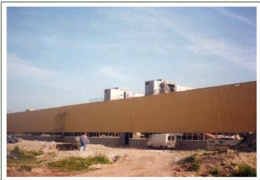
Bordeaux, Frankreich Transmission Plant
